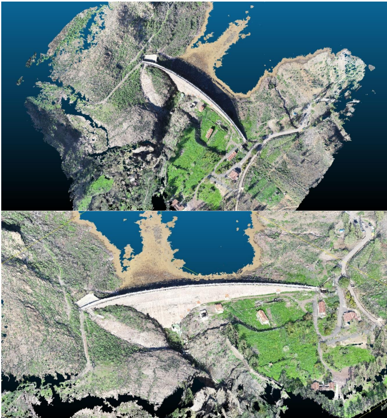
Ilustración N° 4. Nube de puntos obtenida por el vuelo del dron en la presa de Chira.
