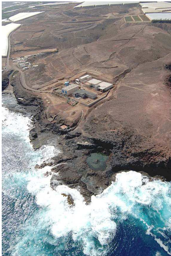
Desaladora de Roque Prieto (CIAGC)
